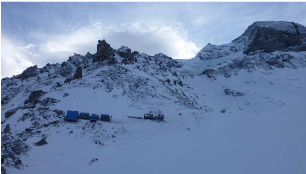
Abbildung 2: Bohrstandort Westgrat (2'560 m ü. M.) unterhalb des "Spitze Steis". TB 1 und TB 2 wurden im Bereich der zwei Plattformen in der Bildmitte abgeteuft.
