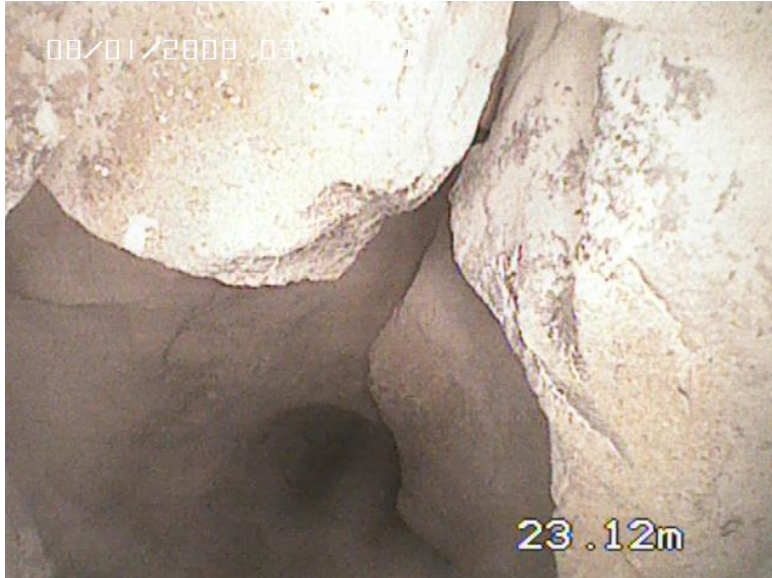
Abbildung 5: Vertikale Kluft im kompakten Kalkstein.
