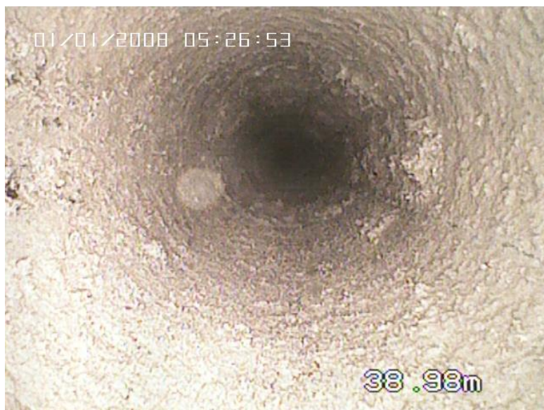
Abbildung 12: Mit Tiefe zunehmend weicherer und feuchteres Mergelsubstrat.
