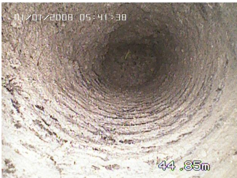
Abbildung 14: Sehr weiches, mergeliges Material. Nachbrechendes Material verhinderte ein Weiterbohren.
