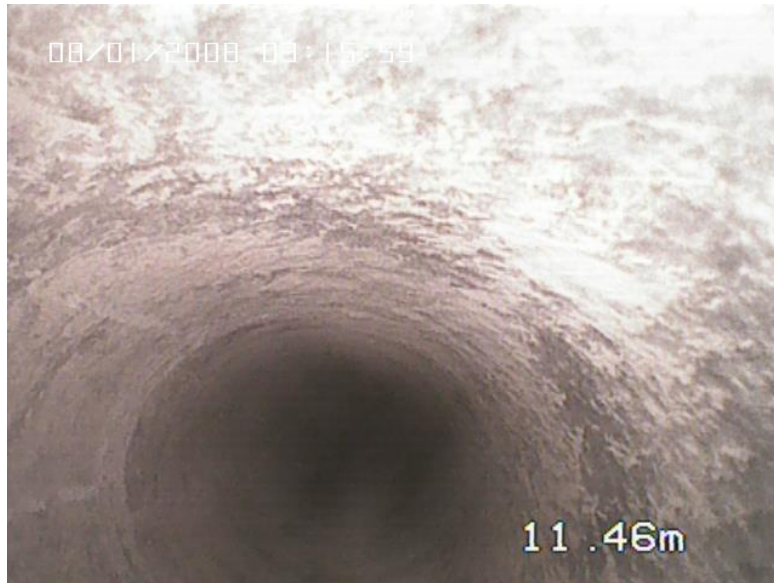
Abbildung 1: Homogener, kompakter Kalkfels.
