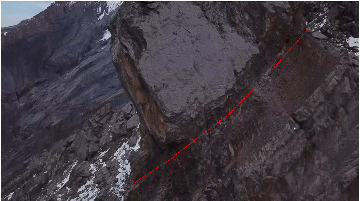
Bild 4: Detail Gipfel Spitze Stei mit Abbruchlinie 20.12.2019, ca. 09:35; Blickrichtung Ost; 23.10.2019
